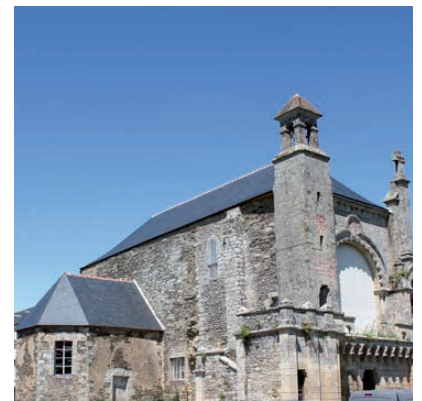
Couverture de la chapelle Saint-Martin
