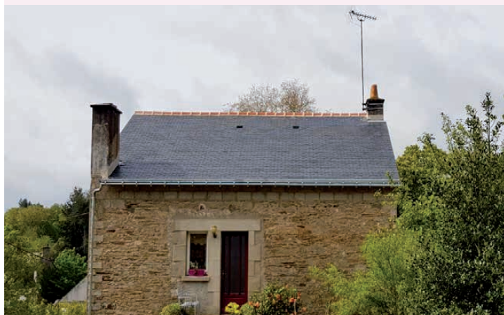
Restauration de la toiture de la maison POTTIER
