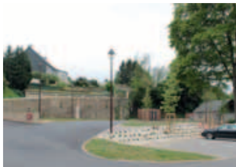
Extension du parking de l'Aiguillon
