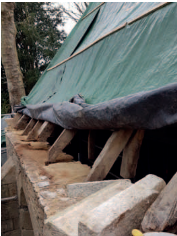
Eléments de charpente.
