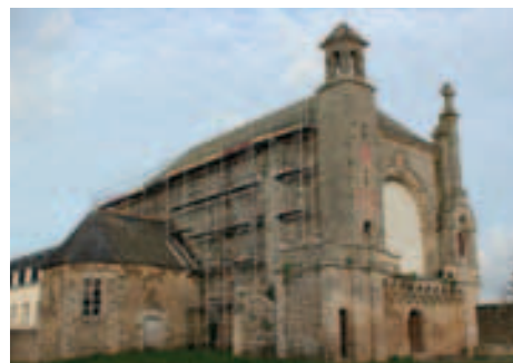
Travaux de restauration/valorisation de la Chapelle Saint Martin
