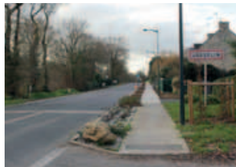
Aménagement cheminement piétonnier La Madeleine – rue Saint Nicolas
